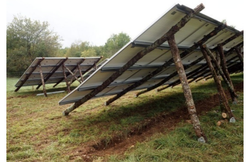
Parc solaire de Carayac avec supports en chêne brut
